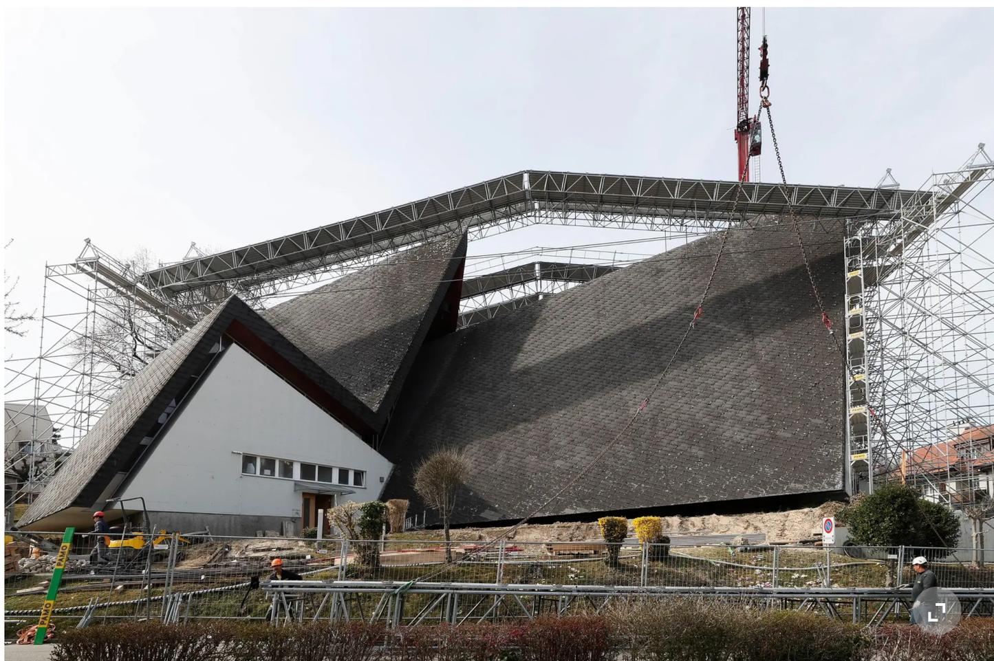
Das Dach der katholischen Kirche in Dielsdorf wird saniert – und muss dazu überdacht werden.
