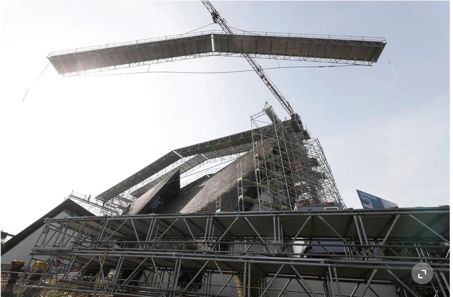
Mit einem Kran werden die Dachteile in Position gehievt.
