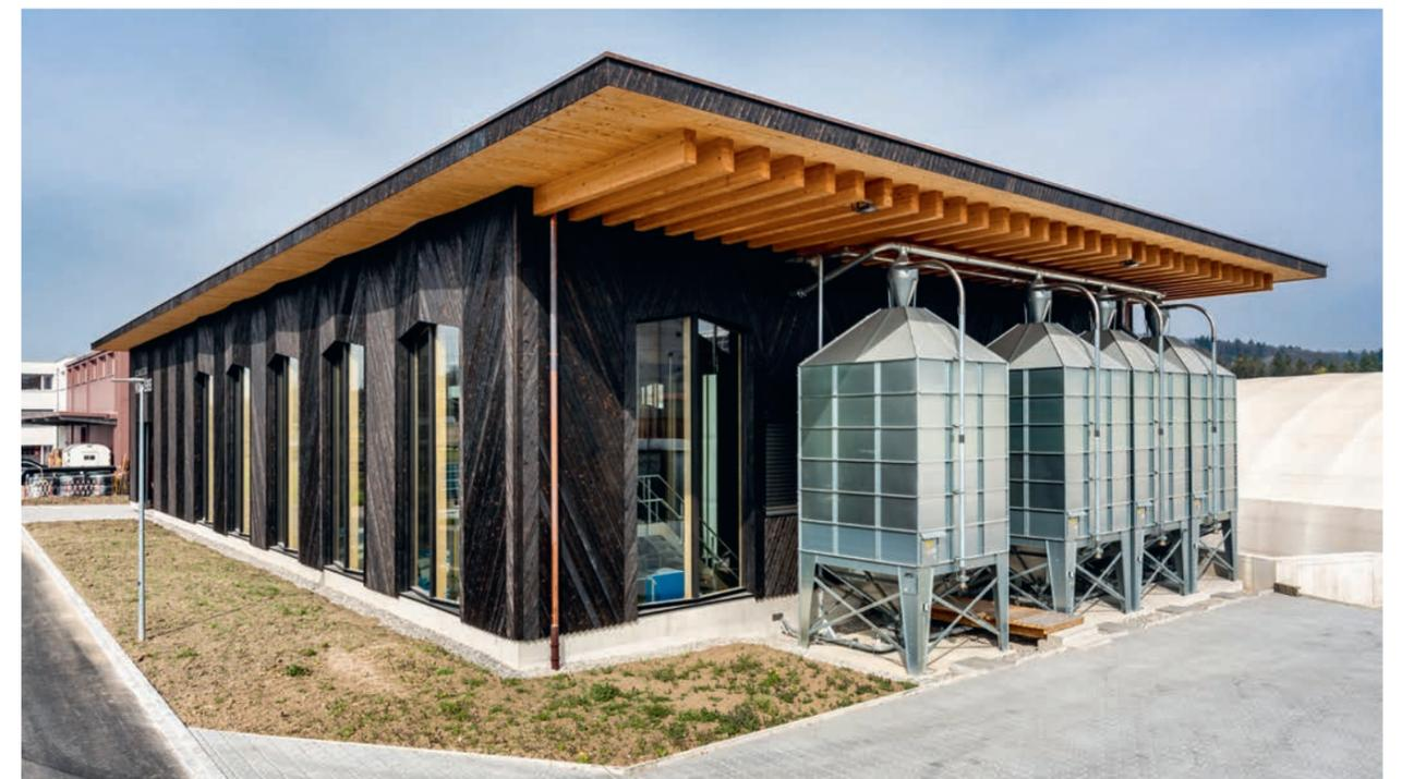
Die dunkle Fassade steht in reizvollem Kontrast zum hellen Holz der Dachunterseite. Die Tannenschalung wurde zum besseren Witterungsschutz karbonisiert.
